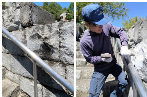
石垣を削ってみたものの…周囲との違和感が気になり、ノミでコツコツ。少しでも見栄えが良くなるようにと、職人さんらしいこだわりはさすがでした！
