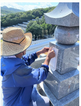
上の写真は追加字彫りをしている時の様子です。左から右へと作業が進む様子を追ってご覧ください。 字彫課の畠山さんが、中川さんの応援を受けながら一緒に施工しました。それにしても…暑そうですね(;^_^:
