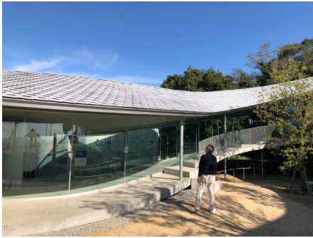
使用された、3万4千枚の庵治石瓦は圧巻です。昨年10月末、県外からのお客様をお連れして「やしまーる」に行ったときの写真です。庵治石瓦でできた、曲線が美しい屋根に見入ってしまいました。
